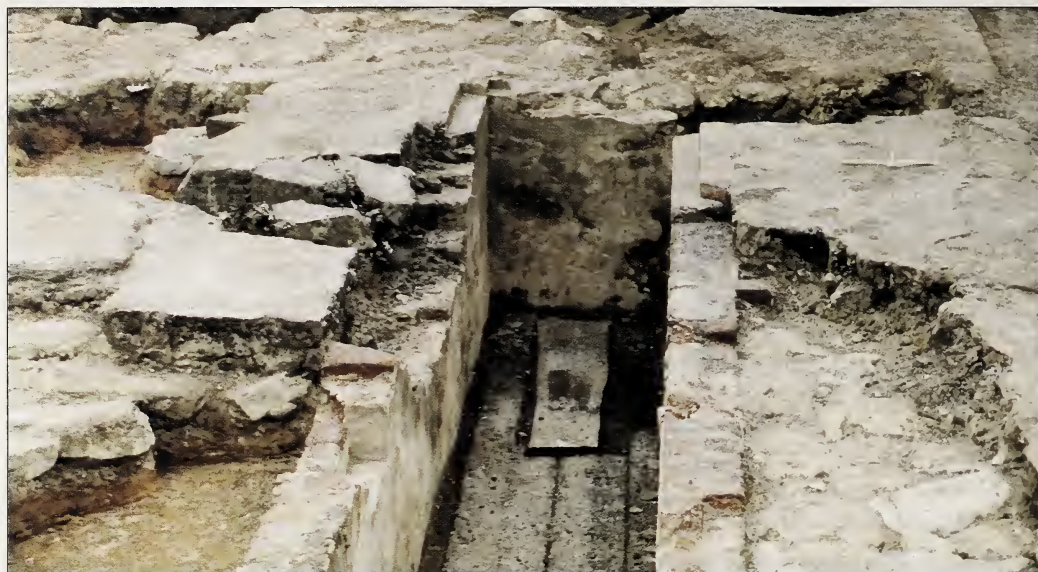
Ryc. 72. Budynek D. Wnętrze zachowanego kanału samochodowego (fot. R. Kaźmierczak)
