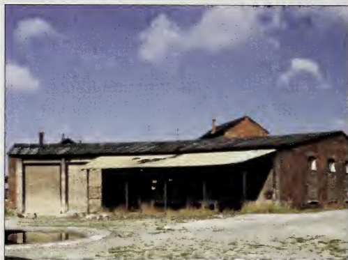
Ryc. 5a. Parowozownia – stan obecny (fot. R. Kola)
