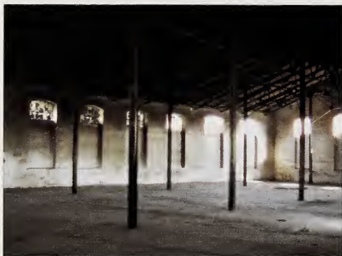
Ryc. 5. Hala parowozowni – stan obecny (fot. R. Kola)
